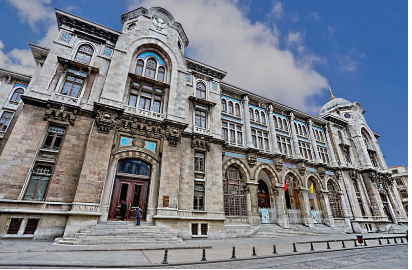
Sirkeci Büyük Postane Binası
