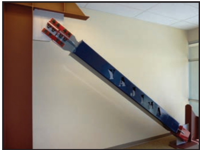
Burkulması Önlenmiş Çapraz Elemanlar
